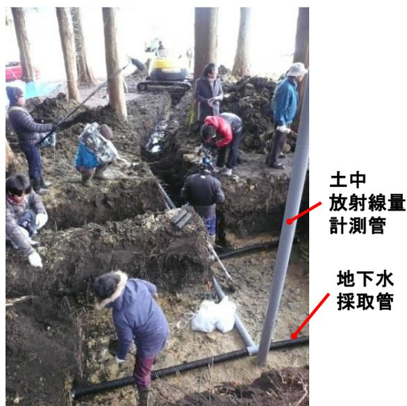
写真3 土中放射線量計測管と地下水採取管敷設作業の様子
