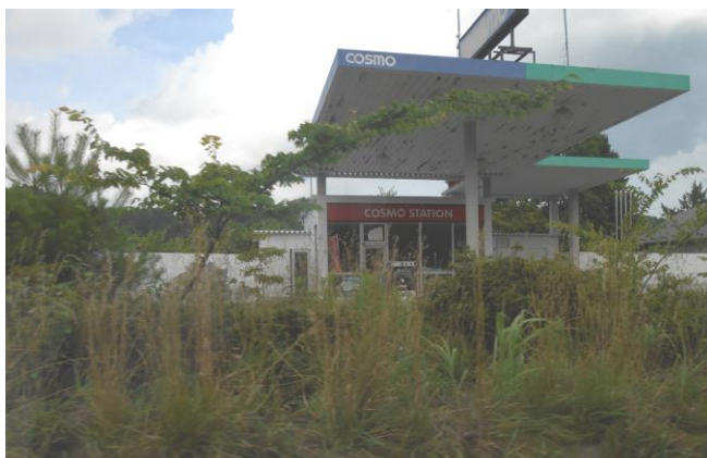
写真2 立入禁止区域(行程②&③) (c)国道114号線沿いの家屋(草木が家に侵入・浸食)
