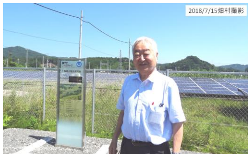
(a) 飯舘村のメガソーラー発電設備(行程⑥) 設置容量 23.37MW, 設置面積 312,317 m 2
