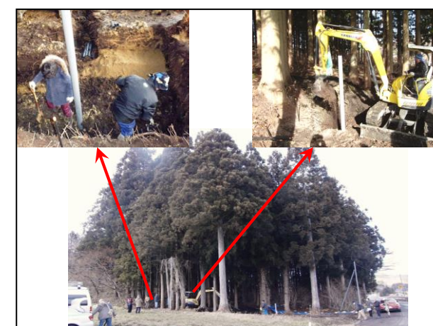
写真3 その場処理の深穴埋め方式除染実験 (2013年12月 福島県相馬郡飯館村)
